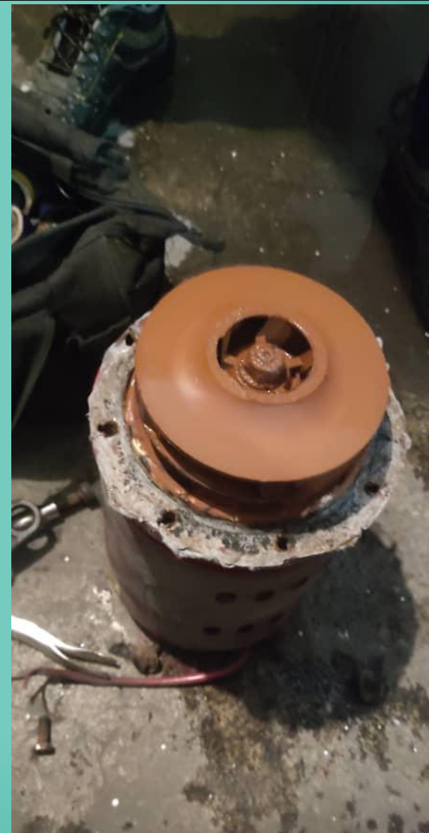
تعمیرات موتورخانه (بلوک ۲)
