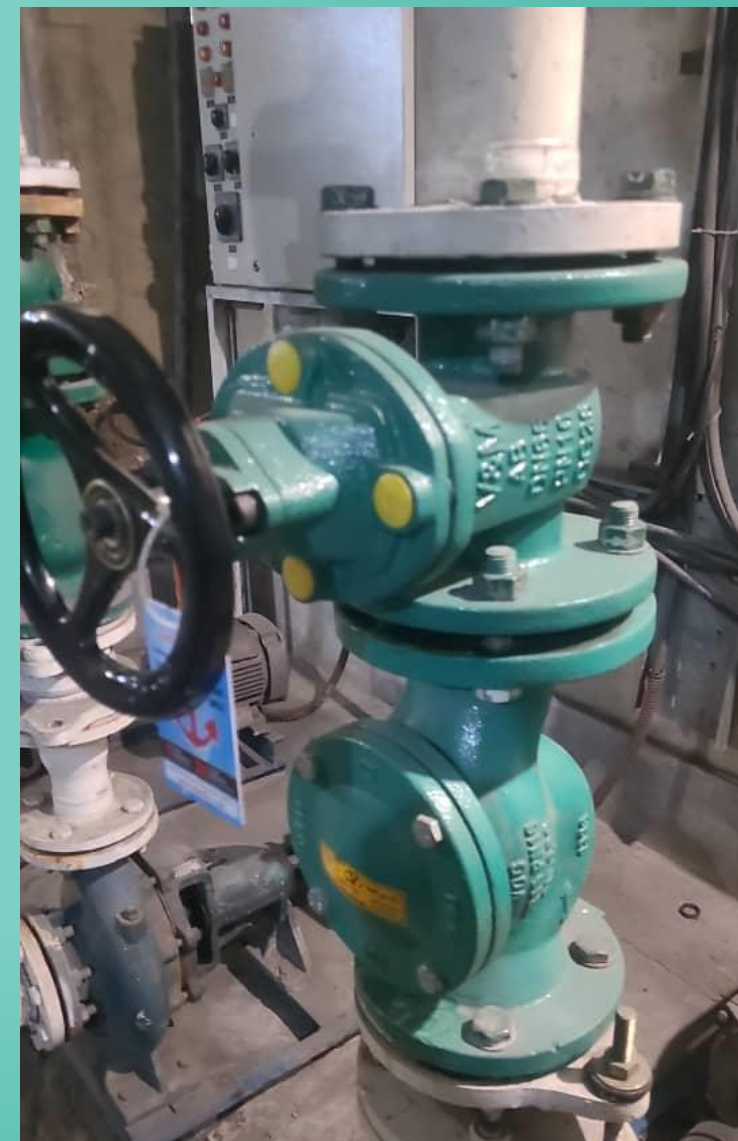
تعمیرات موتورخانه (بلوک ۱)
